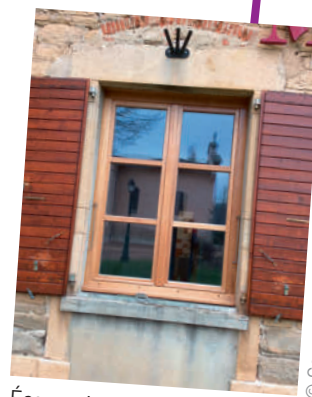
Économie d'énergie : changement de la fenêtre du bureau du Maire
