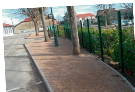
Sécurisation de la cour de l'école
