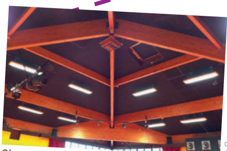
Changement des luminaires de la Maison Prévert
