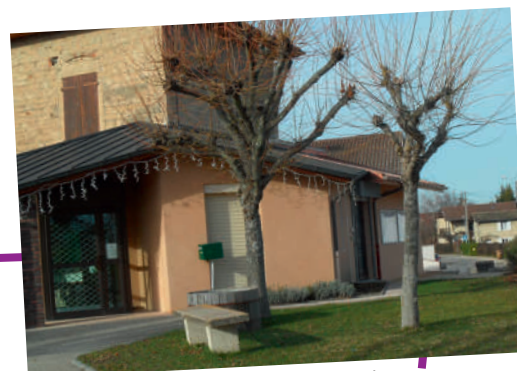
Réfection de la façade Est de la Mairie
