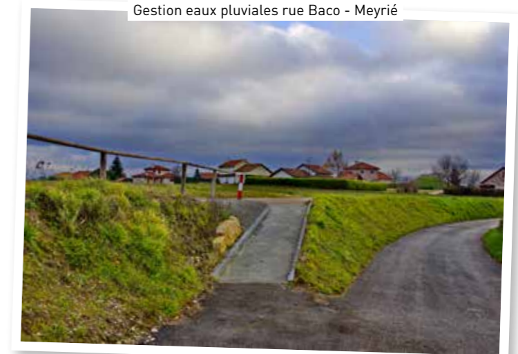
Gestion eaux pluviales rue Baco - Meyrié
